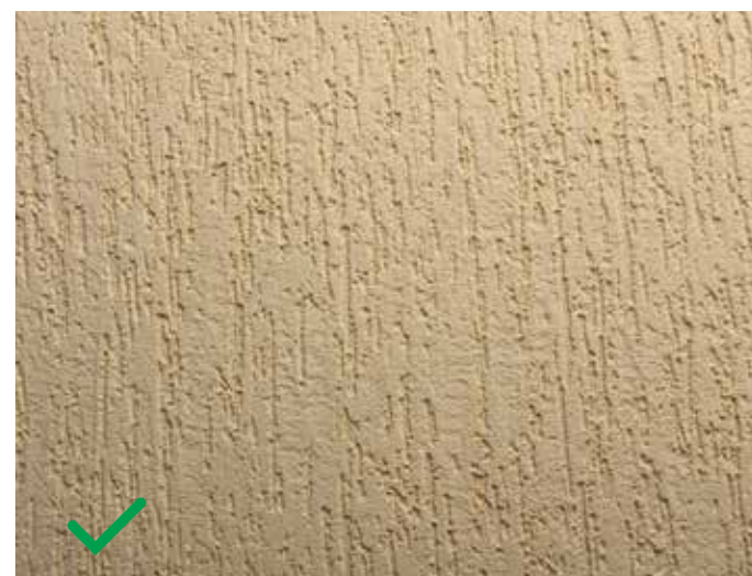
„Dörzsölt” hatású vakolat a CT 16 alapozó festék alkalmazásával
