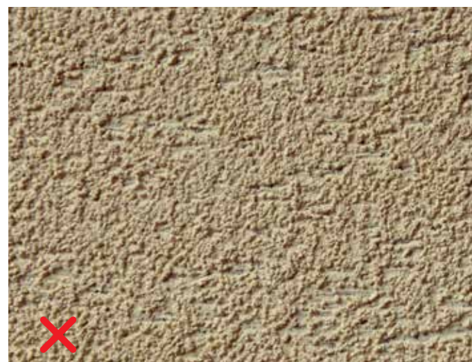
CT16 alapozó festék kihagyásával készült „kapart” hatású vakolat
