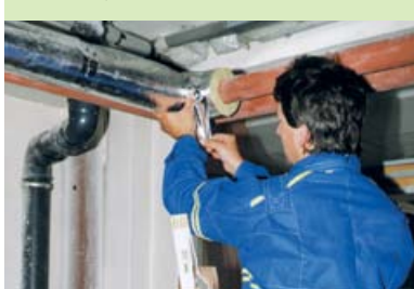
Sarokcsatlakozás alumínium ragasztószalaggal történő átragasztása.
