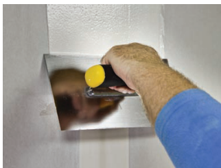
Az illesztést 30 cm szélességben simítsuk le.
