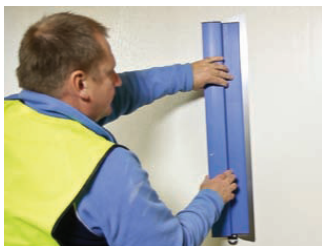
Simítsuk szélesen le a felületet és finoman csiszoljuk meg az esetleges érdességet.
