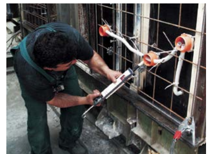
Az átvezetések tömítése (gitt).
