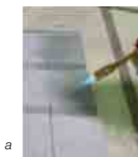
4. ábra: A filces lemezek végein a kapilláris vízfelszívódás megakadályozása (a) helyszínen égetéssel vagy (b) vizes bázisú lakkfestéssel
