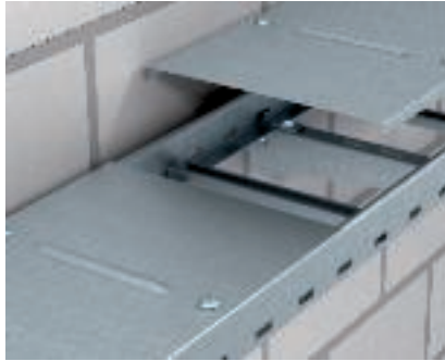
Fedélszerelés A fedelek ráhelyezése és DRL típusú forgóretesszel történő rögzítése a kábellétrára.
