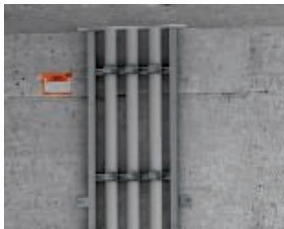
Szerelés oldalfalra Kábelhágcsó falra szerelése rögzítőszegletekkel.
