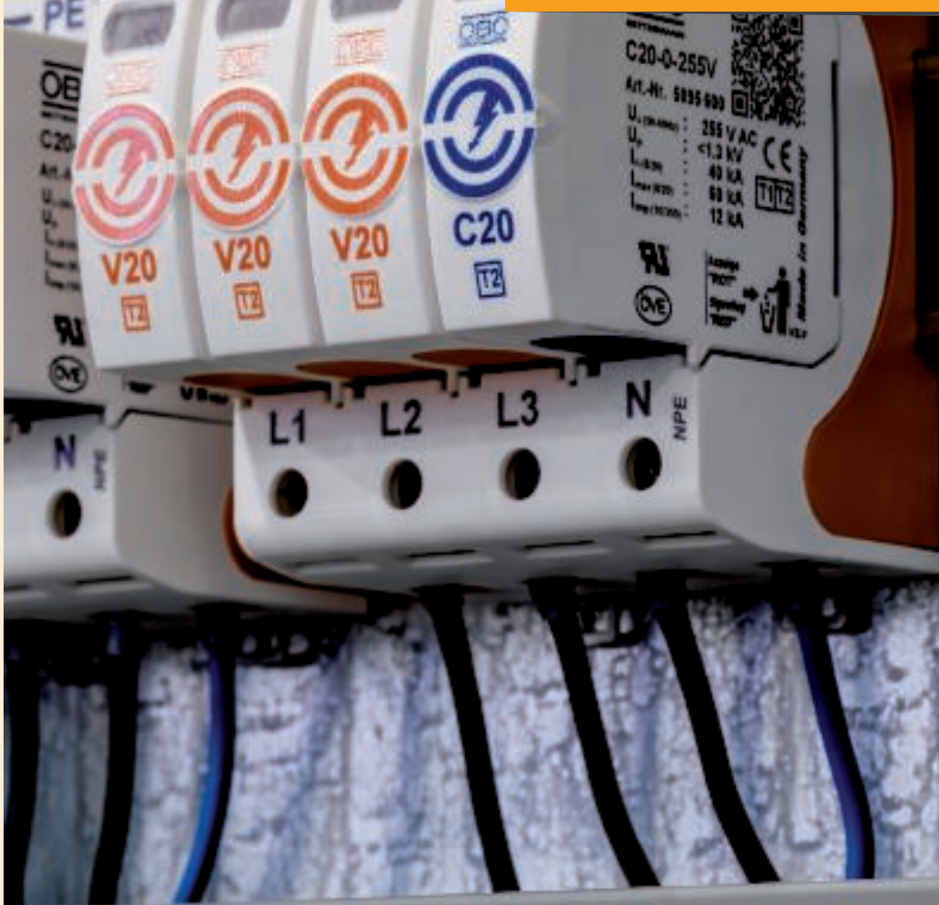
Túlfeszültség-védelem Energiaellátás 2. típusú SPD.
