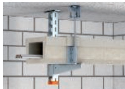
Szerelés E-csatornaként, biztosító menetes rúddal
