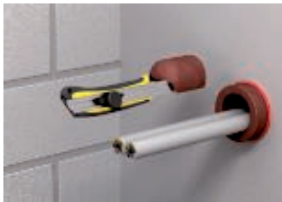
A dugók méretre vágása és behelyezése a csőhájba
