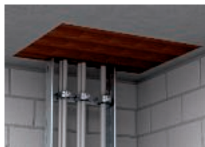
A blokkok földemáttörésbe szorosan illeszkedő beépítése
