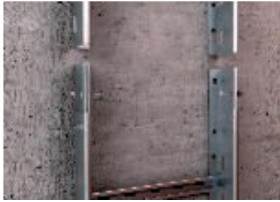
Toldás kialakítás csavarozott hosszoldóval
