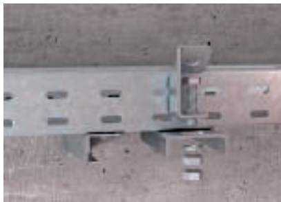
A srég csatlakozóelem rögzítése
