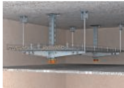
Kétszintes földműfüggesztés kétoldali konzolelhelyezéssel
