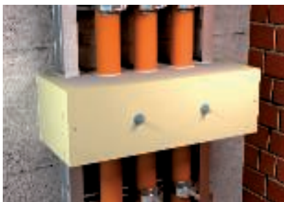
Hatásos alátámasztás ZSE90 húzásmentesítővel
