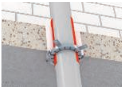
Szerelés a födém alsó részén, fémdübelekkel
