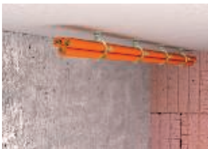
Kötegelt kábelhelyezés a mennyezet alatt
