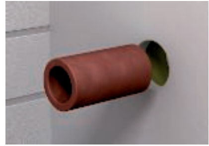
A csőháj beillesztése a szerelt falba
