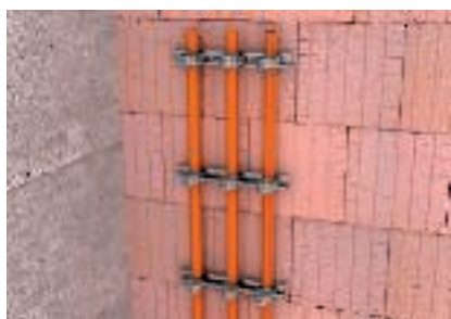
Függőleges kábelnyomvonal kialakítása kengyeles bilincsekkel a falon
