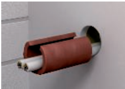
A csőháj felvágása már beépített kábelek esetén
