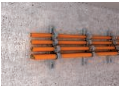
A kábelek vízszintes szerelése a falon a kengyeles bilincsekkel
