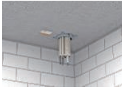
Szerelés a födém alsó részén, fémdübelekkel
