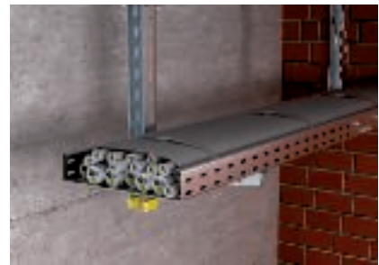
A kábelköteg bandázsolása a tar- tószerkezeten
