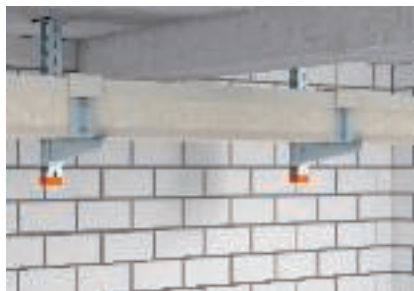
Függesztett mennyezeti szerelés, I-csatornaként
