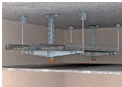
Kétszintes földműfüggesztés kétoldali konzolelhelyezéssel
