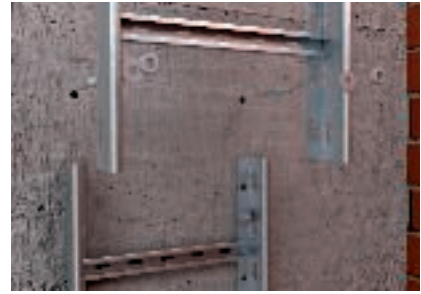
Toldás kialakítása hosszoldó nélkül
