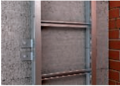
Kábelhágcsó közvetlen szerelése a tömör falra
