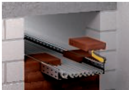
A méretre vágott blokkok beépítése
