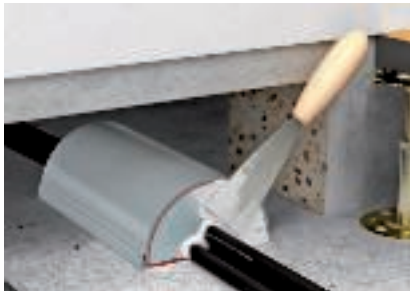
A felület füstgáz tömör lezárása ASX-szel
