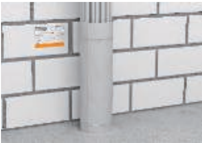
A maradék nyílás lezárása habarccsal és a jelöltábla felszerelése
