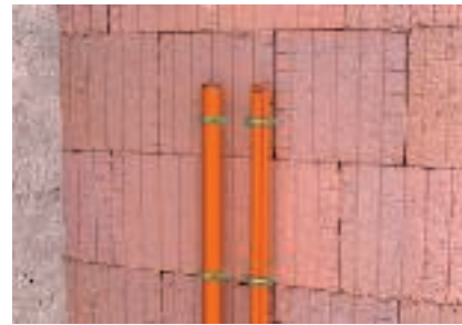
Függőleges kábelhelyezés egyedi és csoportos kialakítással a falon
