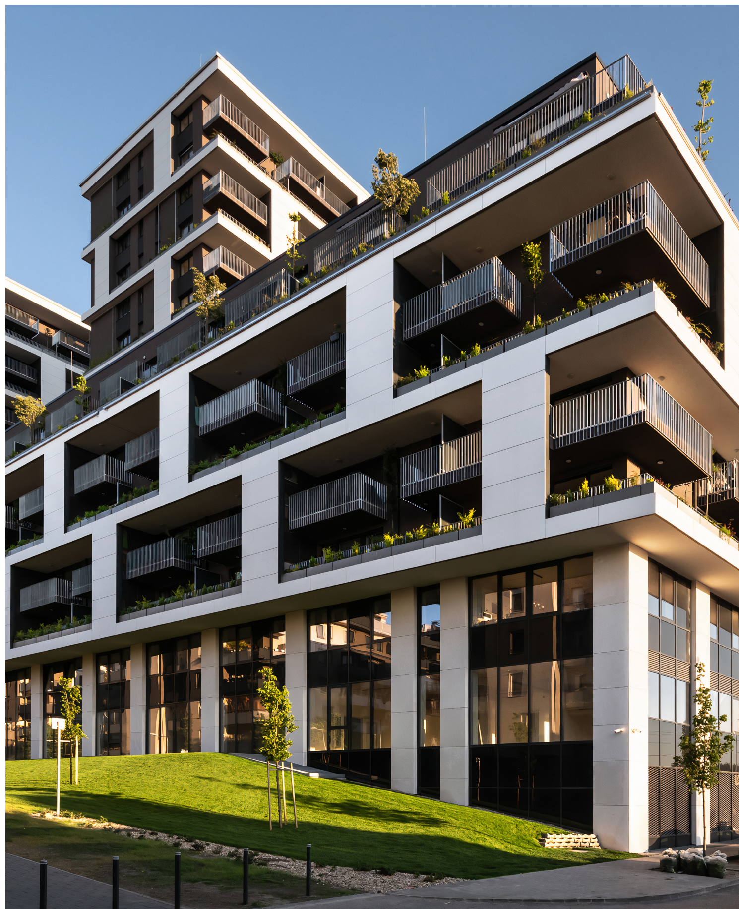
Metrodom Panoráma lakópark
