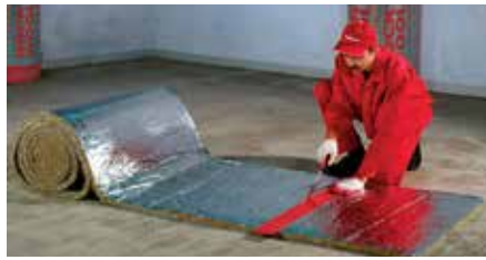
1. lépés – A szigetelés pontos méretre vágása
