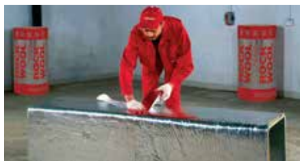
4. lépés – A hossz- és keresztirányú illesztések leragasztása öntapadó alumínium szalaggal
