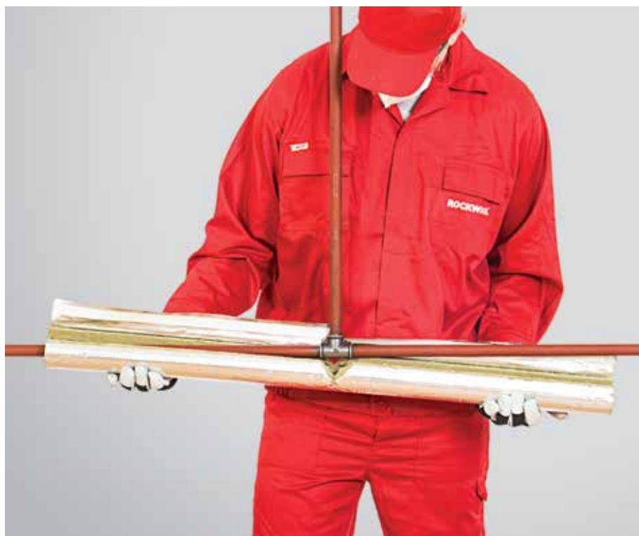
17. kép – Elemek felhelyezése a T elágazás száraira
