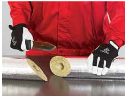
5. kép – A csőhéjat két 45°-os elemre vágjuk
