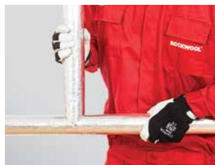
18. kép – Csatlakozó elemek hézagmentes illesztése
