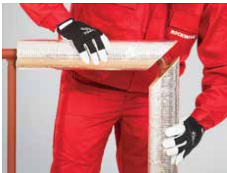
7. kép – Szigetelő elemek összeillesztése
