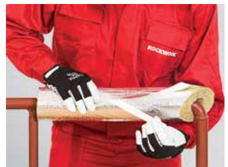
6. kép – A hosszirányú illesztések összeragasztása
