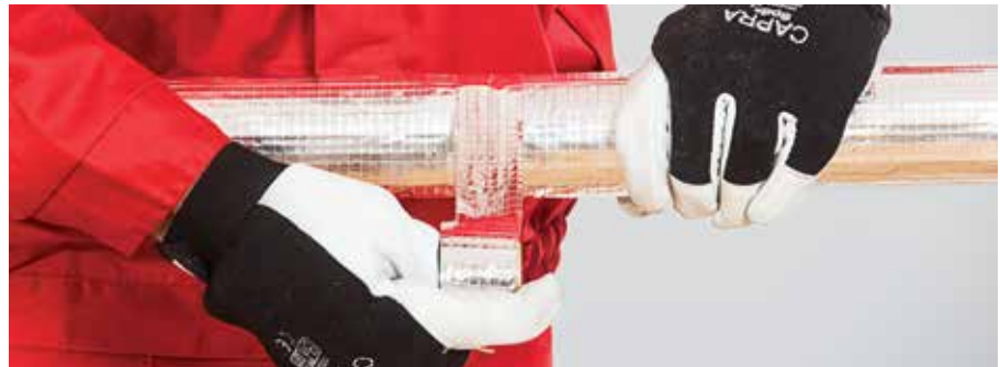
4. kép – Illesztések lezárása alumínium szalaggal
