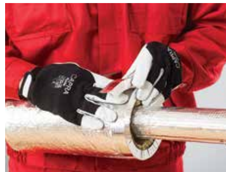
22. kép – A szigetelés lezárása alumínium szalaggal
