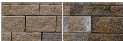
Kerítés hidrofobizált anyagból
